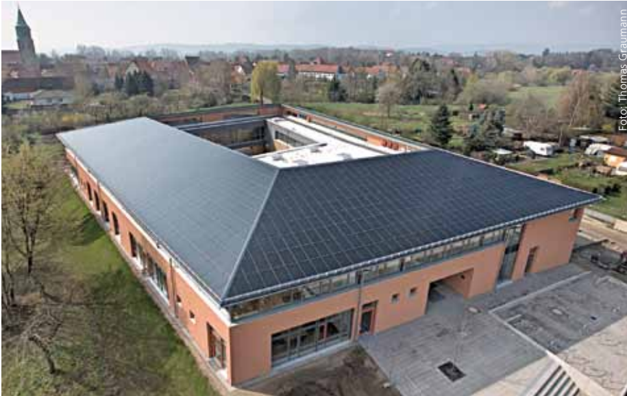
Die 2012 als Passivhaus fertiggestellte Grundschule in Gronau (Leine) ist dank Photovoltaikanlage ein Plusenergiegebäude.
