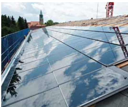
Die Montage der Photovoltaikmodule bei Indachsystemen nach dem Überschuppungsprinzip verbessert die Hinterlüftung und damit die Leistung.
