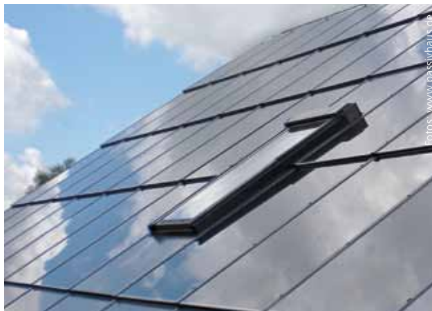
Mit Blindmodulen – wie hier am Dachfenster – sind Indachsysteme auch architektonisch ansprechend.
