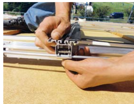
▲ Durch die blitzstromtragfähige Verbindung wird die Unterkonstruktion zur Fangeinrichtung
