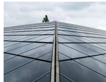
▲ Täuschend echt: Blindmodule und PV-Module ergeben eine homogene schwarze Dachfläche
