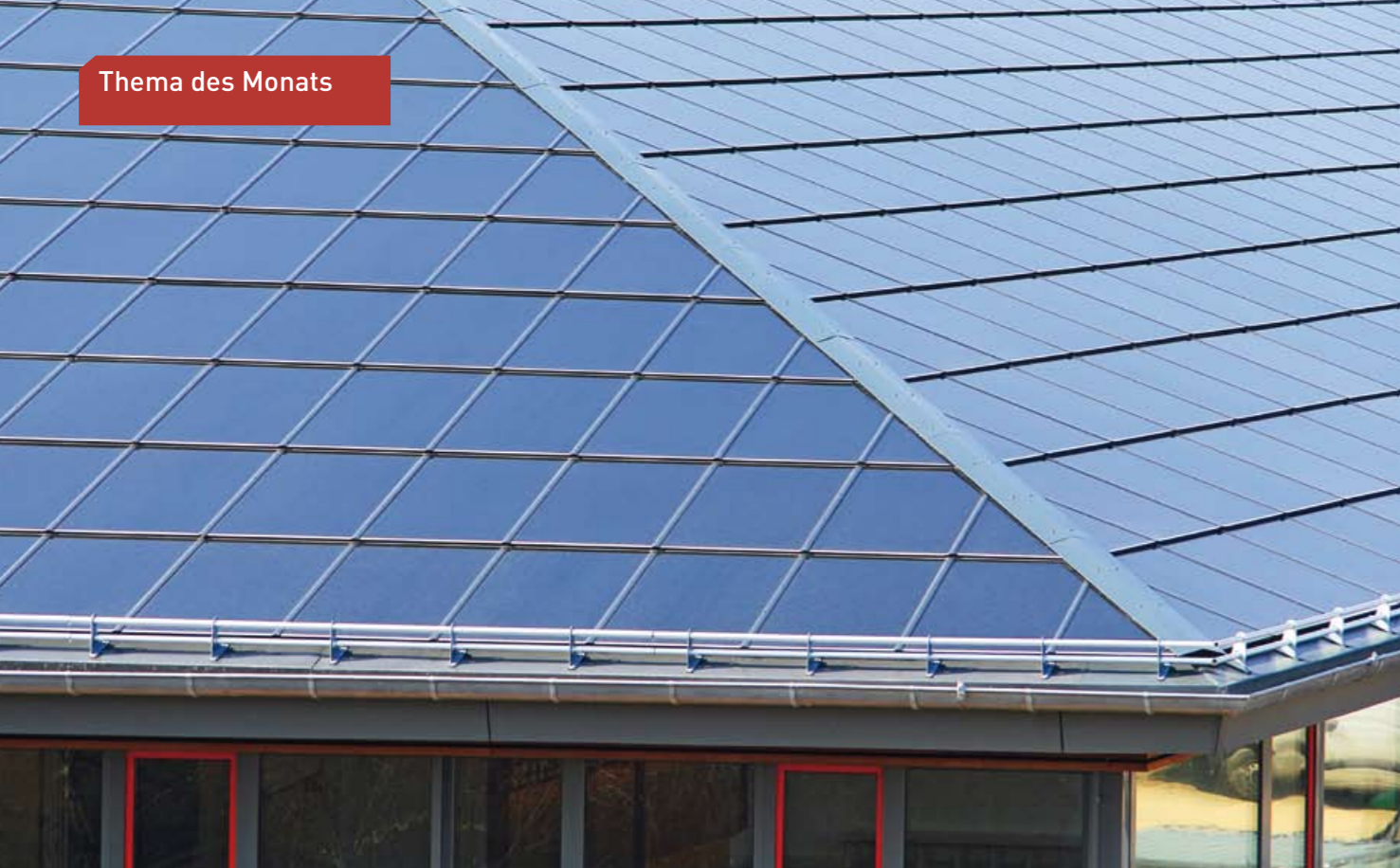
▲ Schönes Solardach: Gratabdeckung und Schneefangsystem sind elegant in die schwarze Photovoltaikdeckung der Grundschule in Gronau integriert
